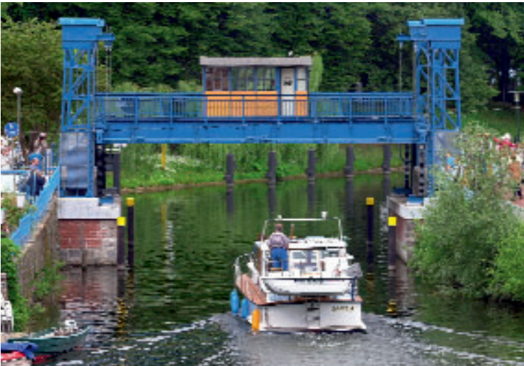
Fluss Elde, Hubbrücke in Plau am See
